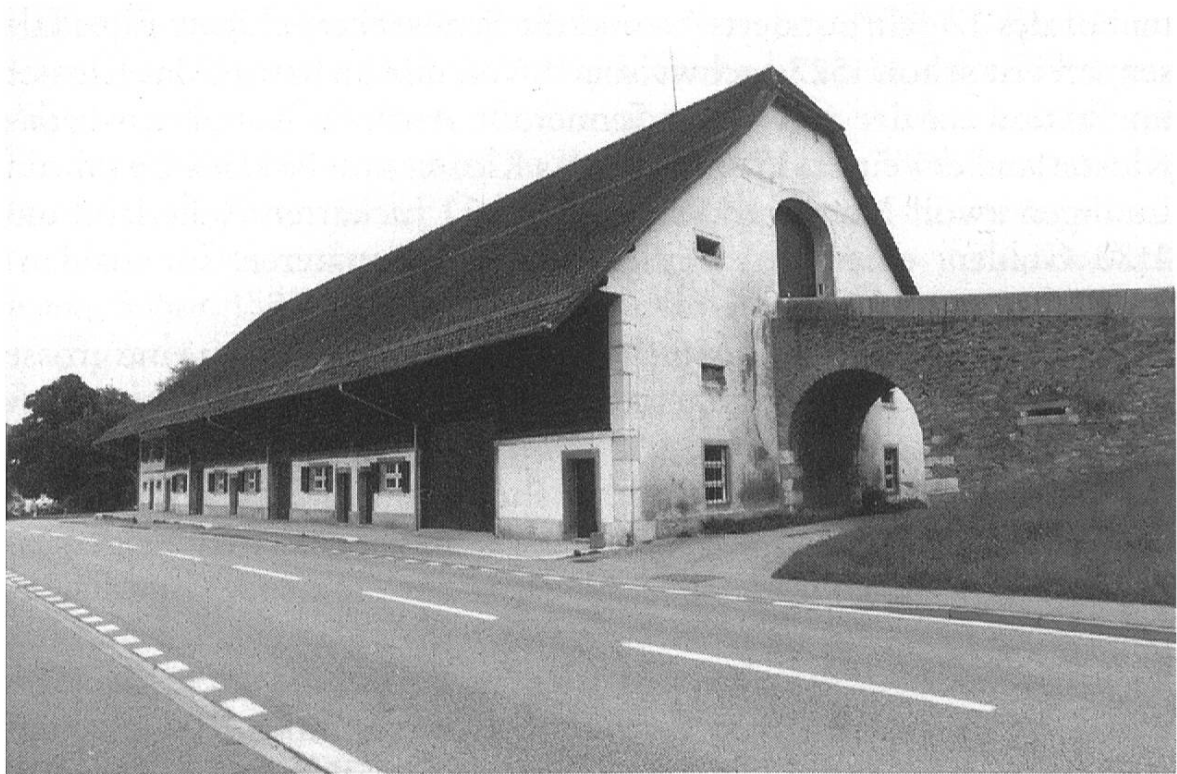
Die 1840–1842 vollständig neu errichtete Weierhofscheune steht in der Bautradition der älteren St. Urbaner Scheunen. Aufnahme Dieter Ruckstuhl
