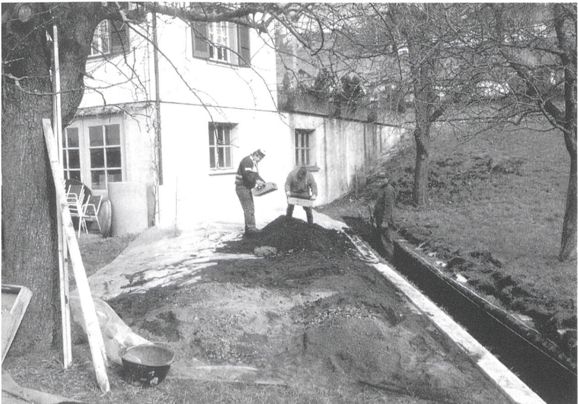
Bild oben und Bild unten: Leitungsgraben in Wauwil-Obermoos.
