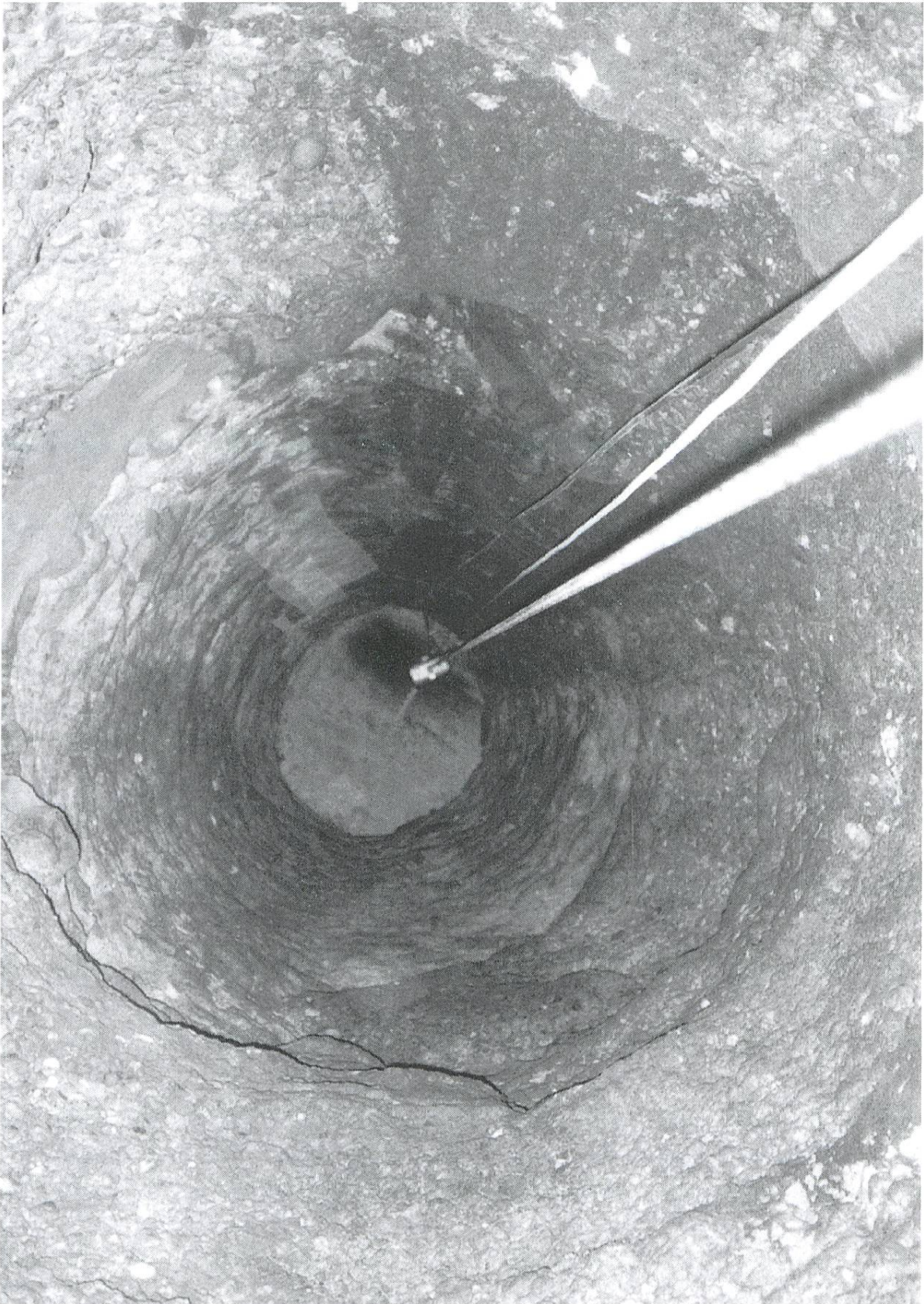
Sodbrunnen: Blick aus rund 15 Metern Tiefe gegen den Deckel des Sodbrunnens. Auf rund 60 Metern Tiefe des Brunnens liegen Schutt und Baumstrünke. Am Rand des Bildes sind Kettenzug, Sicherungsseil und Scheinwerferkabel sichtbar.
