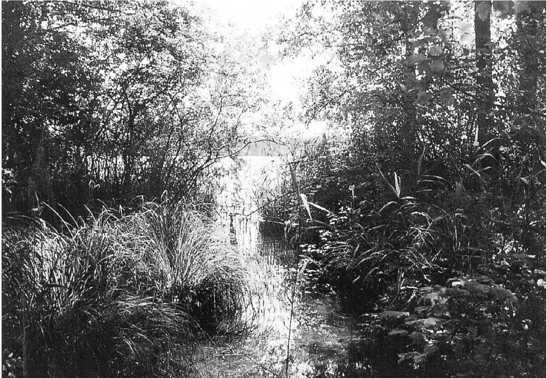
Abbildung 15: Beim Seebachausfluss sind heute von diesem «wärhaften beständigen werck» nur noch einige Pfahlstümpfe und morsche Balken zu finden.
