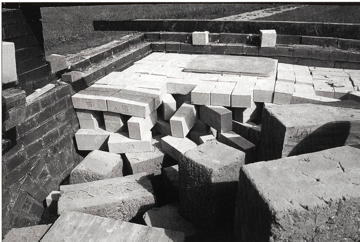
Abbildung 11: Abdeckung aus Maschinenrohlingen über den grossformatigen Rohlingen.
