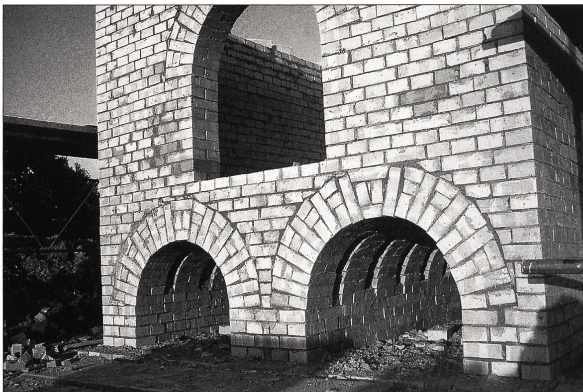
Abbildung 5: Der Kammerofen während des Baus. Blick in die Feuerungskanäle und auf die Beschickungsöffnung.
