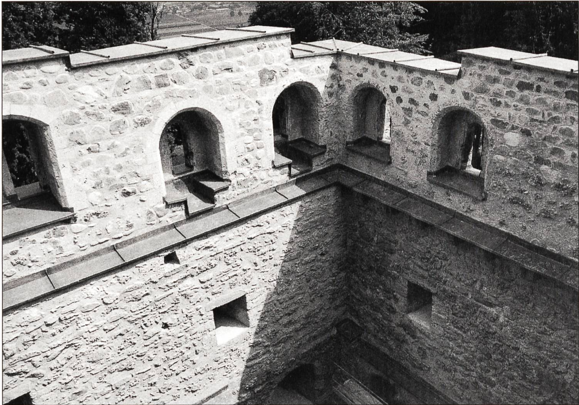
Die Ost- und Südwand innen im endgültigen Zustand.
