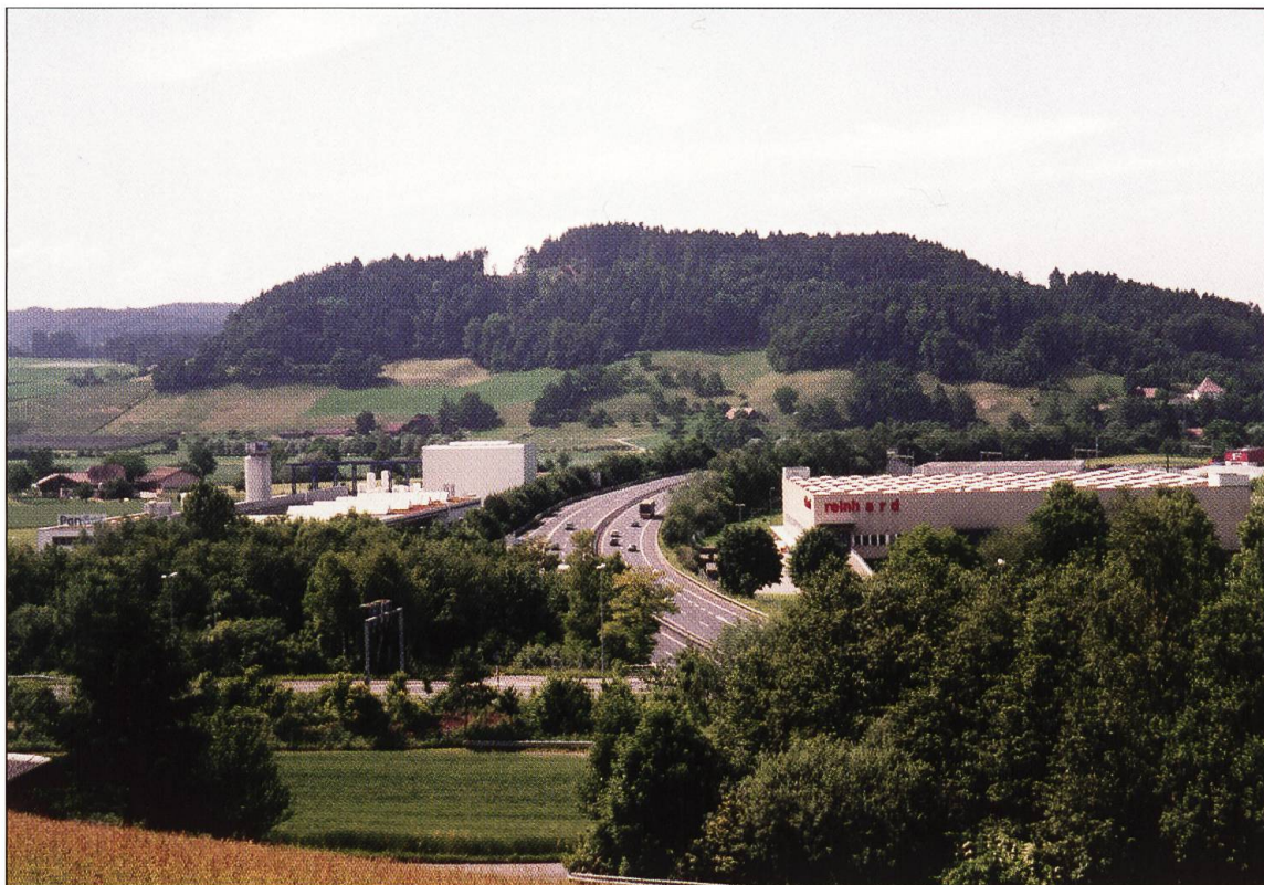
Autobahnanschluss, Zustand im Sommer 2000.
