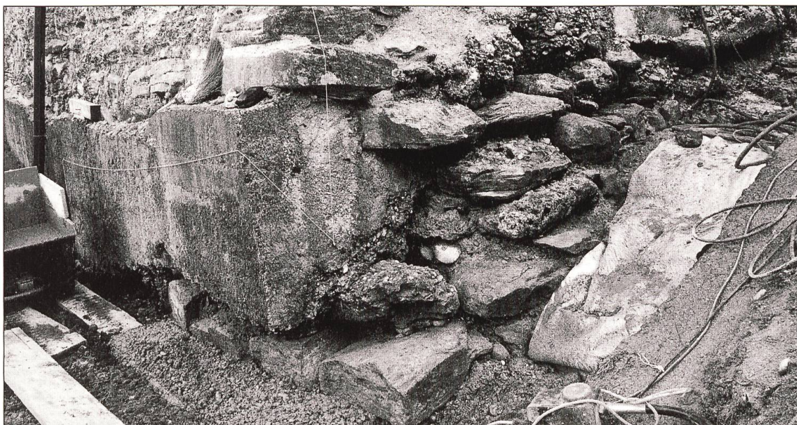
Die gefährdete Nordwestecke mit der alten und neuen Unterfangung des Fundamentes. In der Fortsetzung nach links befindet sich der Hohlraum unter der Grundmauer, der wahrscheinliche Durchlass beim Schleifen der Burg.
