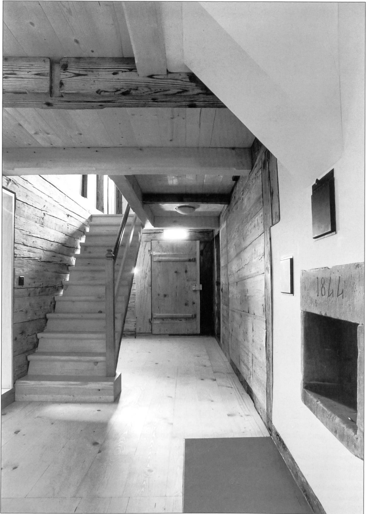
Detailansicht des Hausganges im Hauptgeschoss, links der Treppenlauf ins Obergeschoss, rechts die Einfeuerung von 1844 für den Kachelofen der Bauernstube. Zustand nach der Restaurierung.
