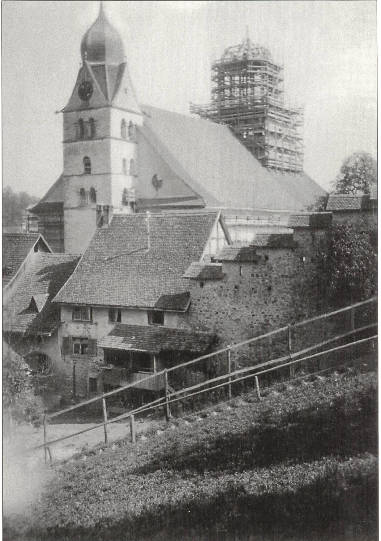
Südwestansicht der Pfarrkirche St. Peter und Paul aus dem Jahre 1929 mit dem Baugerüst für den neuen Glockenturm. Foto: Staatsarchiv St. Gallen (Aufnahme: Adolf Gaudy)
