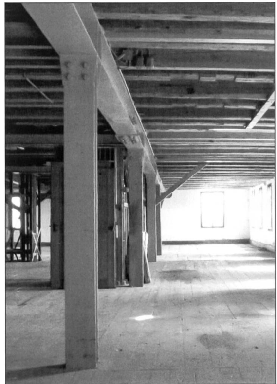
Stahlstütze und Balken im Produktionsbereich.
