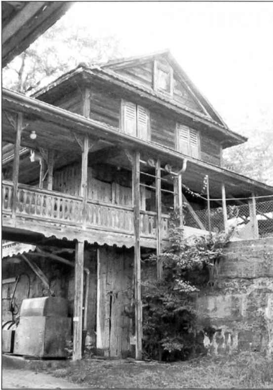
Ökonomiegebäude neben der Alten Steiner- mühle mit Laubengangverbindung und Aufzugsvorrichtung.
