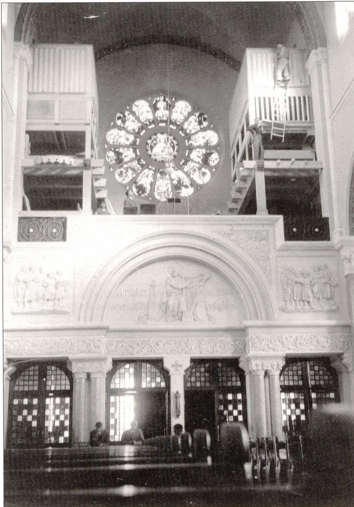
Montage der OAGW-Orgel in der Sankt-Martins-Kirche Olten. Das mehr als waghalsige Gerüst ist wohl kaum SUVA-konform... (1931).
