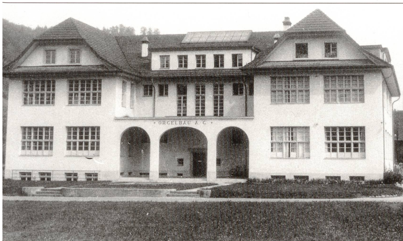
Die 1927 an der Ettiswilerstrasse 24 in Willisau erbaute «Orgelfabrik» der Architekten Tetmajer, Debrunner und Blankart, Luzern.
