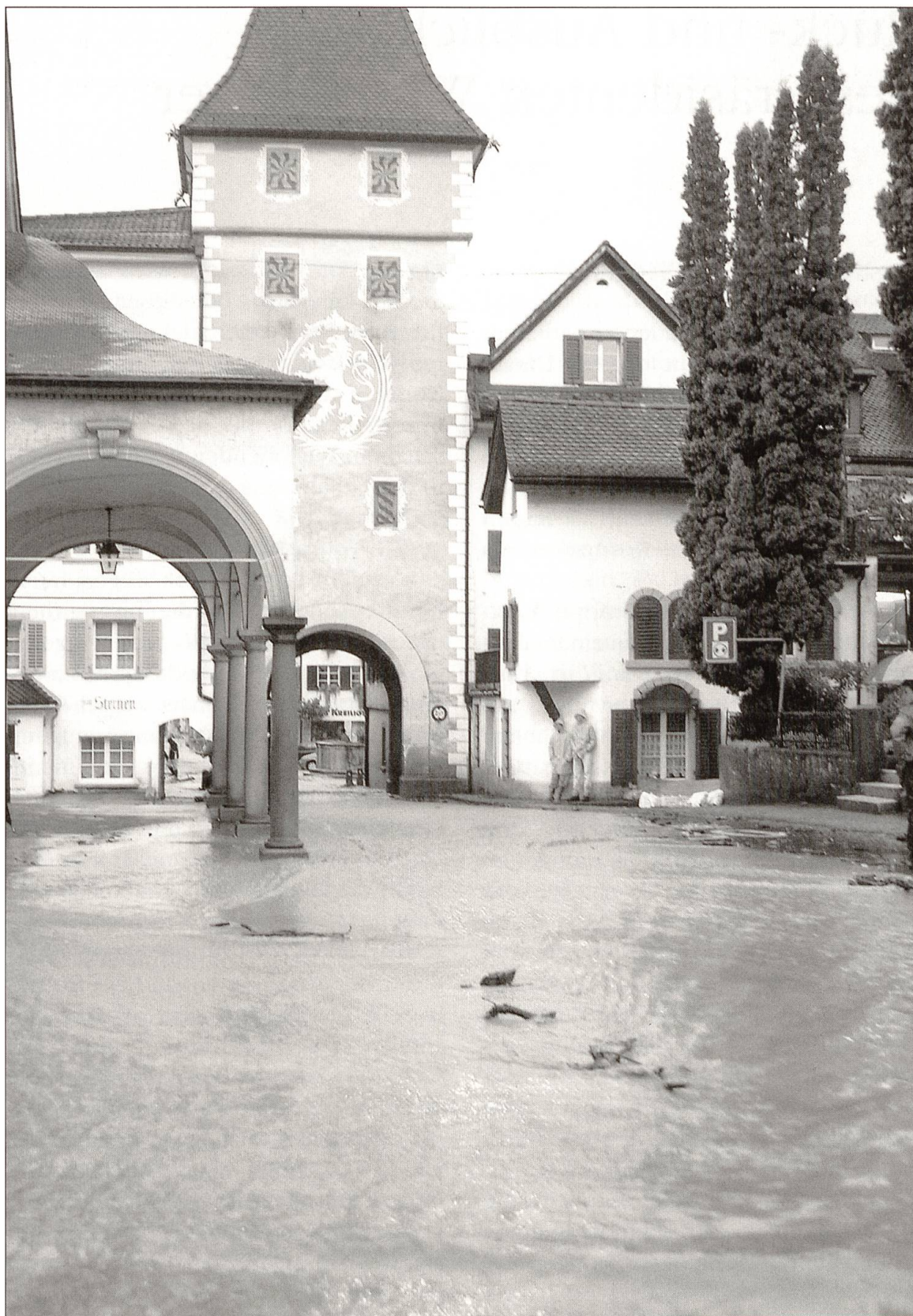
Willisau: Der Platz vor der Heilig-Blut-Kapelle und dem Oberen Tor bekam durch das Hochwasser ein neues Gesicht. Foto: Andy Schaller, Willisau
