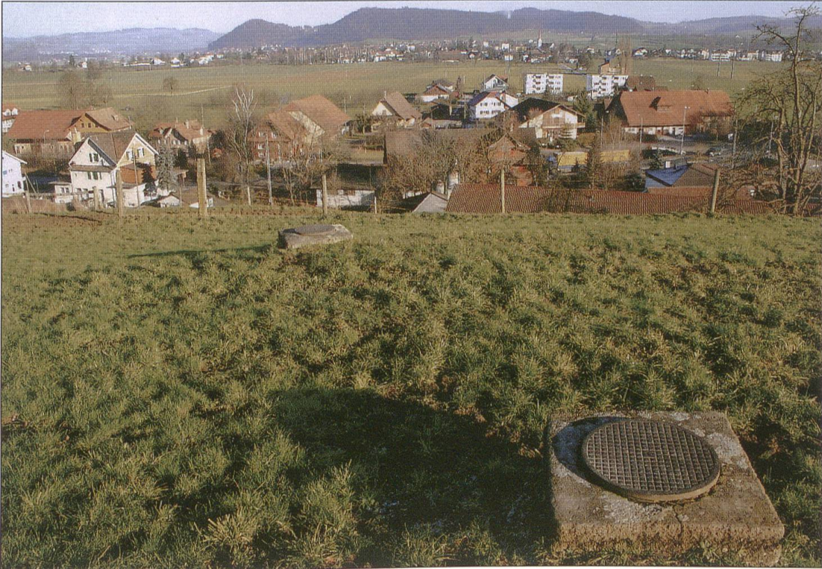
Die Brunnenstuben in der Buchweid. Sie werden heute noch im ursprünglichen Ausmass genutzt.
