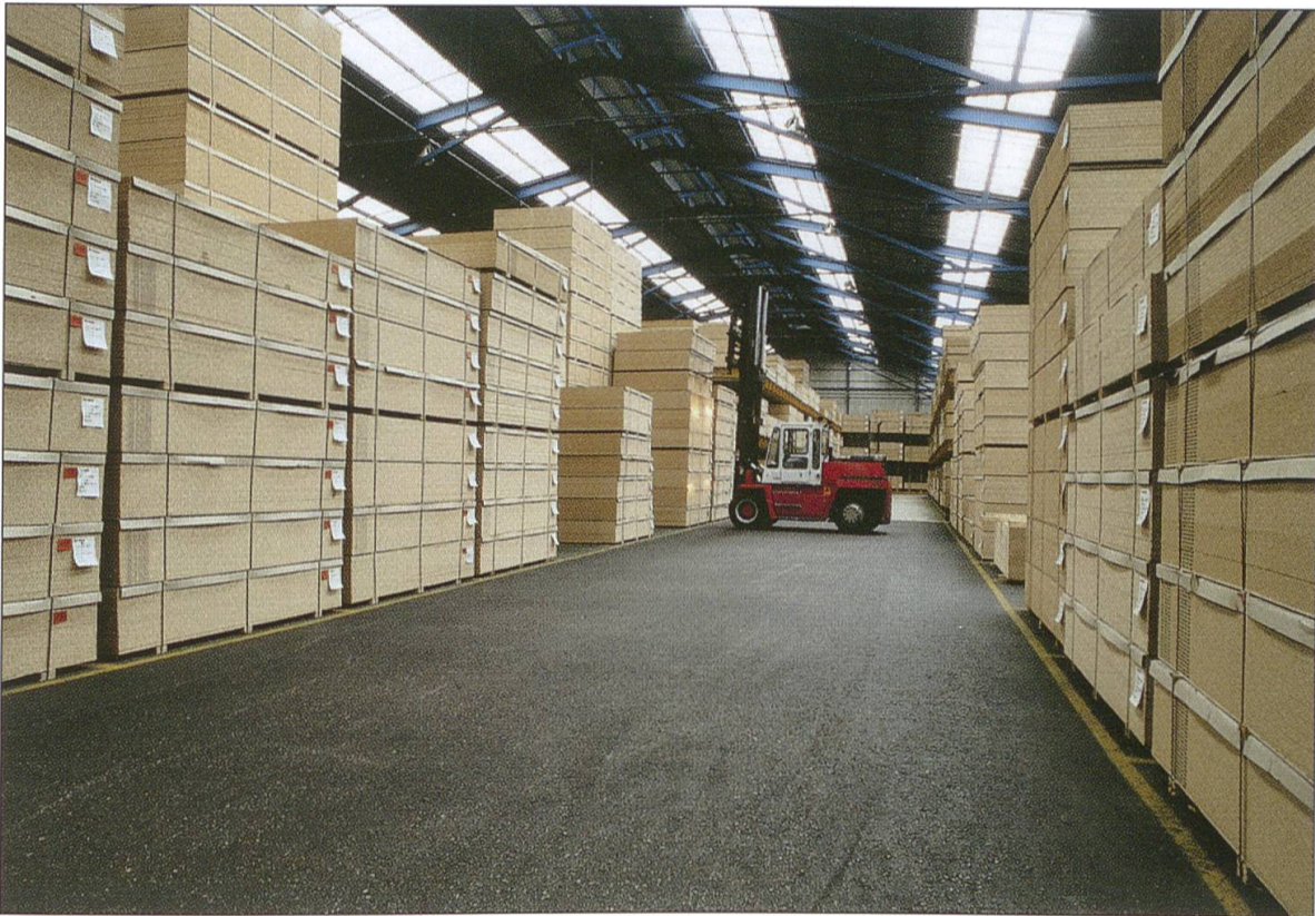
Lagerhalle für Fertigprodukte.
