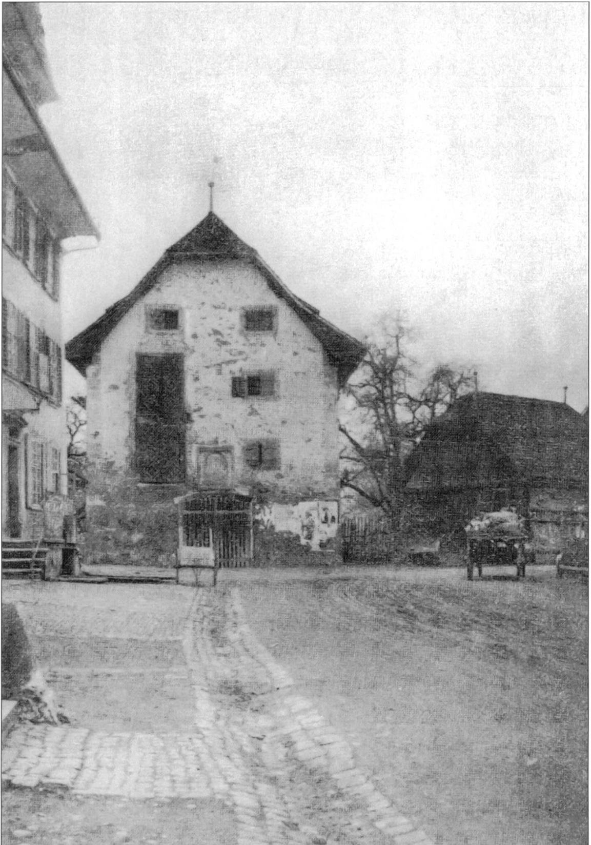
Die Zehntenscheune oder Kornschütte an der Hergiswilerstrasse. Links ist ein Teil der Fassade des abgebrochenen Josefhauses (Suppigerhaus oder Gesellenhaus) zu sehen. Rechts neben der Zehntenscheune steht das alte Spritzenhaus (Feuerwehrhaus) von Willisau-Stadt.
