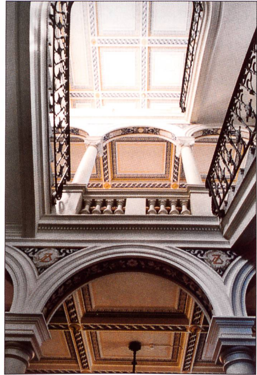
Der markante Treppenaufgang.
