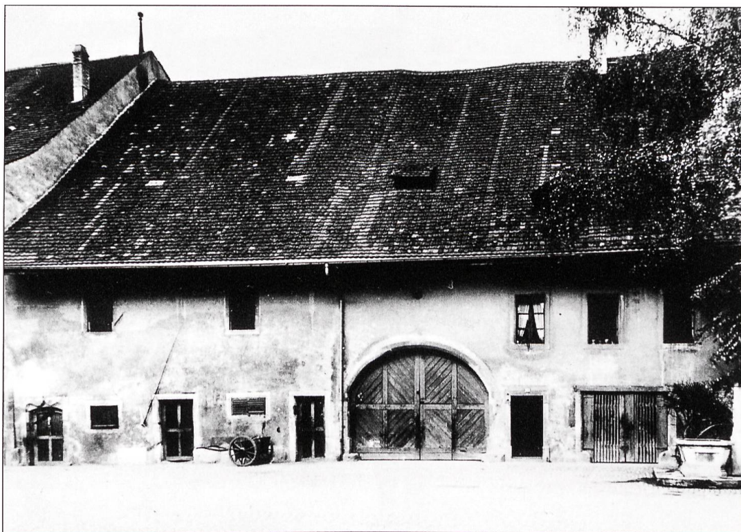
Die Bauamtsscheuer – 1938 zum Kommandoposten des Feldarmeeekorps 2 umgebaut.
