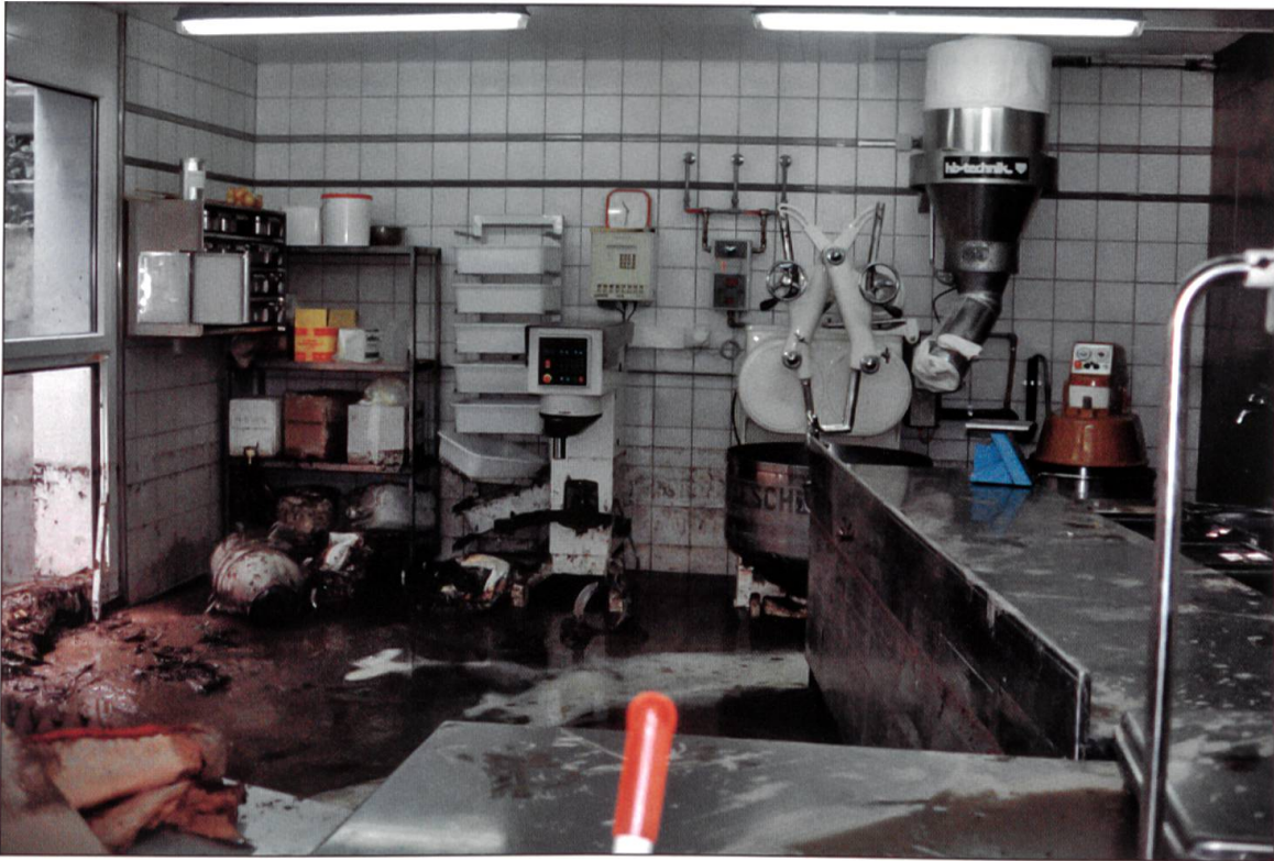
Ansicht der «Teigerei». An den Wänden ist der Wasserstand gut sichtbar.
