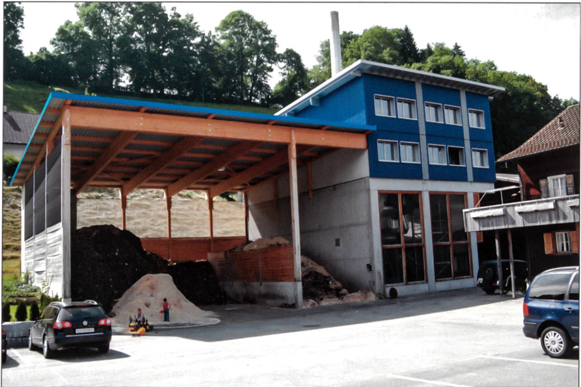
Das Dorf Luthern wird heute durch den Wärmeverbund des Sägewerks Christen geheizt.
