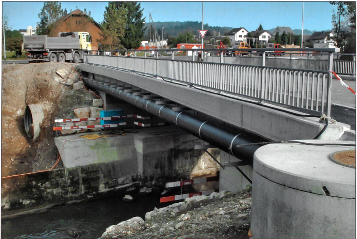
Die neue Wiggerbrücke im Aeschwubr.
