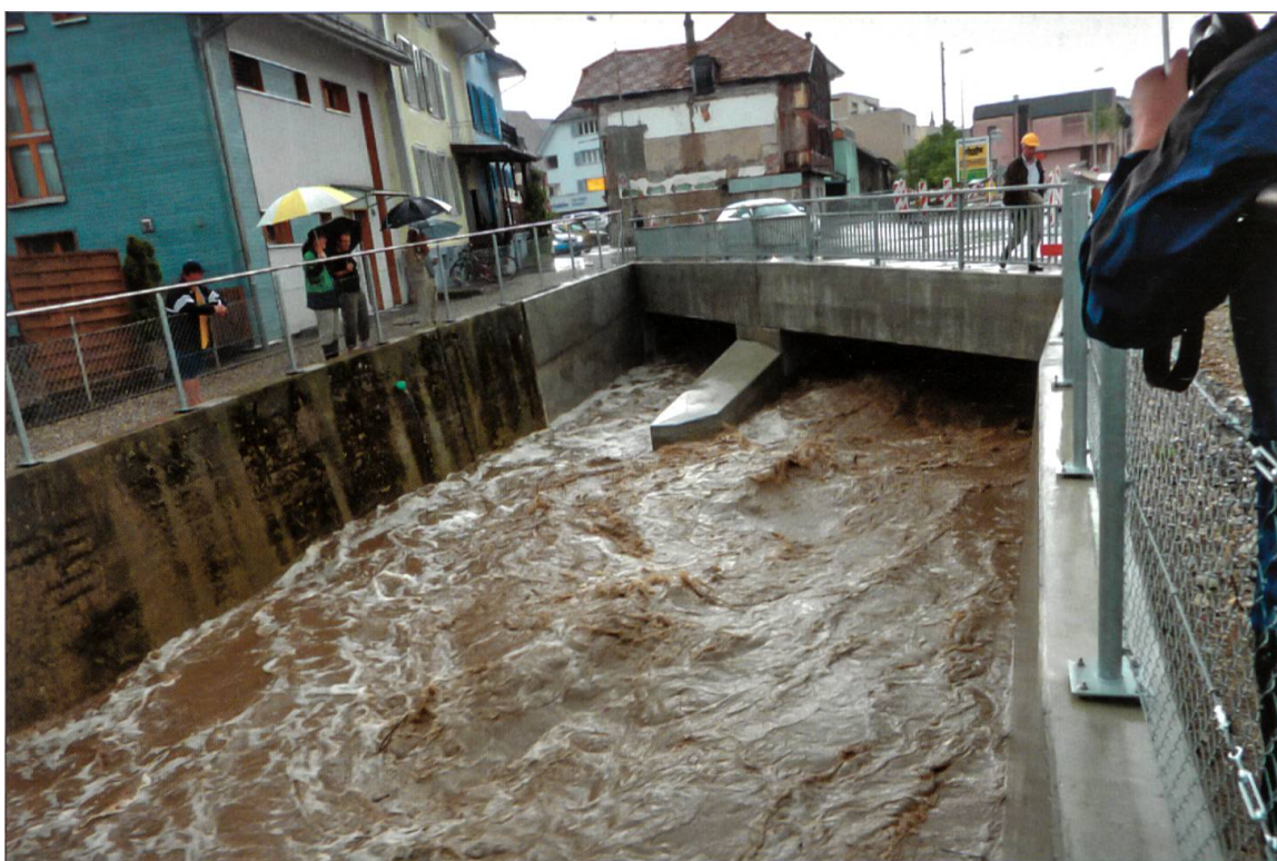
Hochwasser am 26. Mai 2009. Zusammenfluss des Wassers aus dem Altlauf (links) und dem Entlastungskanal (rechts) bei der Löwenbrücke. Foto Roland Koller
