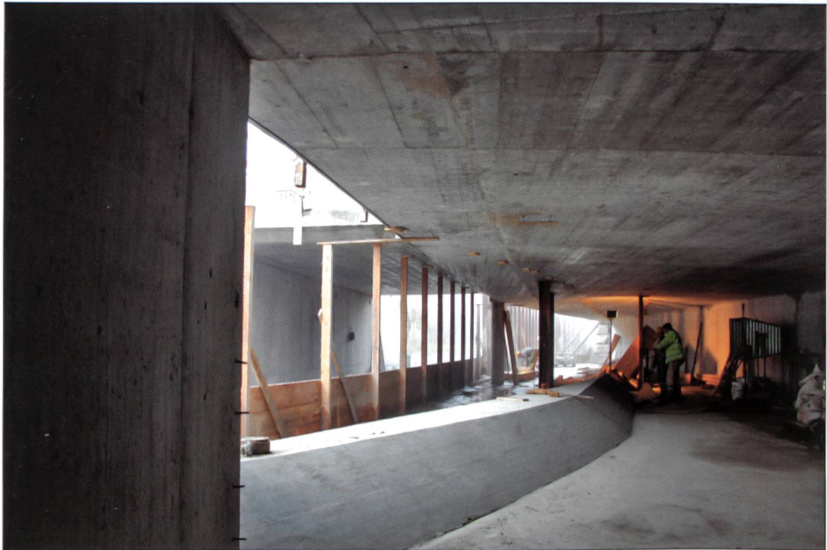
Bau des Einlaufbauwerks, im Vordergrund das Streichwehr. Blick aus dem Entlastungskanal in den Oberlauf der Enziwigger.
