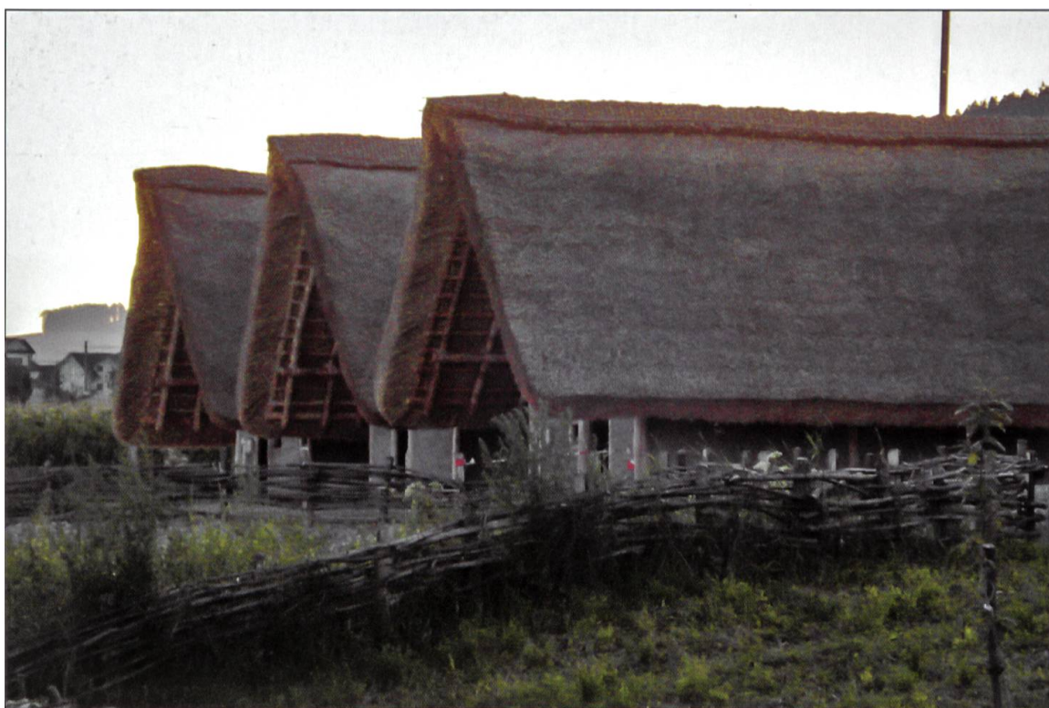
Pfahlbausiedlung in Wauwil mit regionalen Materialien: Holz, Lehm, Schilf.
