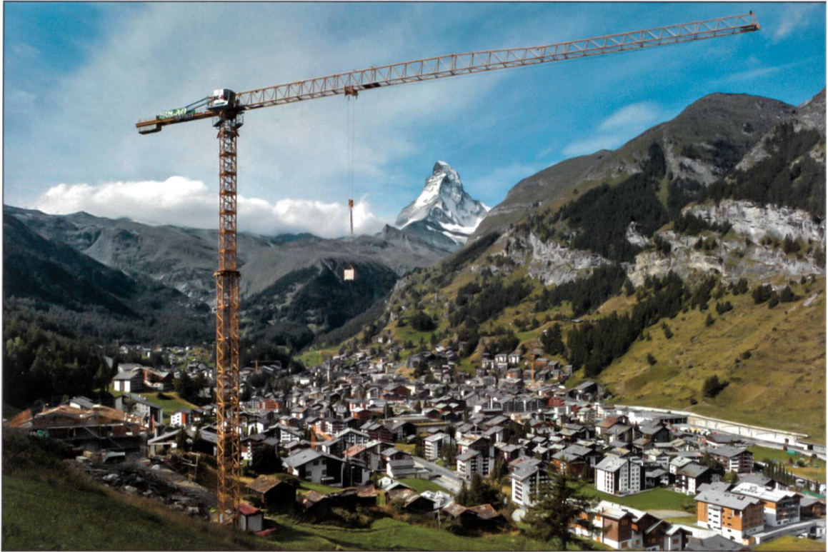
Liebherr-Turmdrehkran 130 EC-B6 vor «prominenter» Kulisse.
