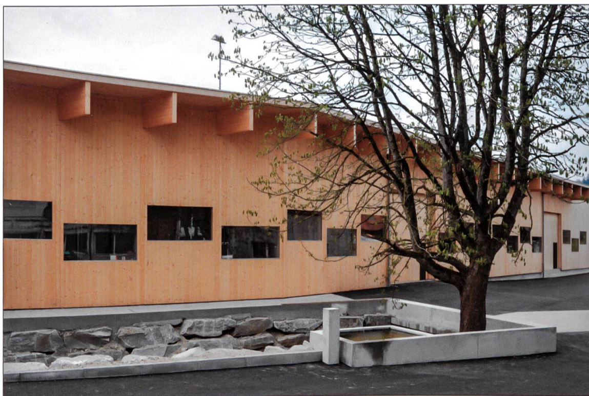
Die neue Produktionshalle am Werkplatz in Grossdietwil wurde im Herbst 2008 erstellt.
