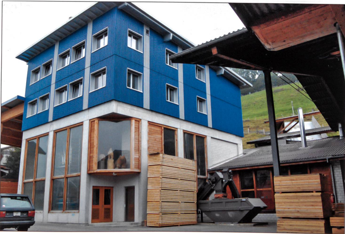
Das neue Heizhaus des Sägewerks Christen. Links der neue Ofen, rechts im Altbau der alte Ofen. Er dient als Reserveofen und kann bei Reparaturen angeheizt werden.
