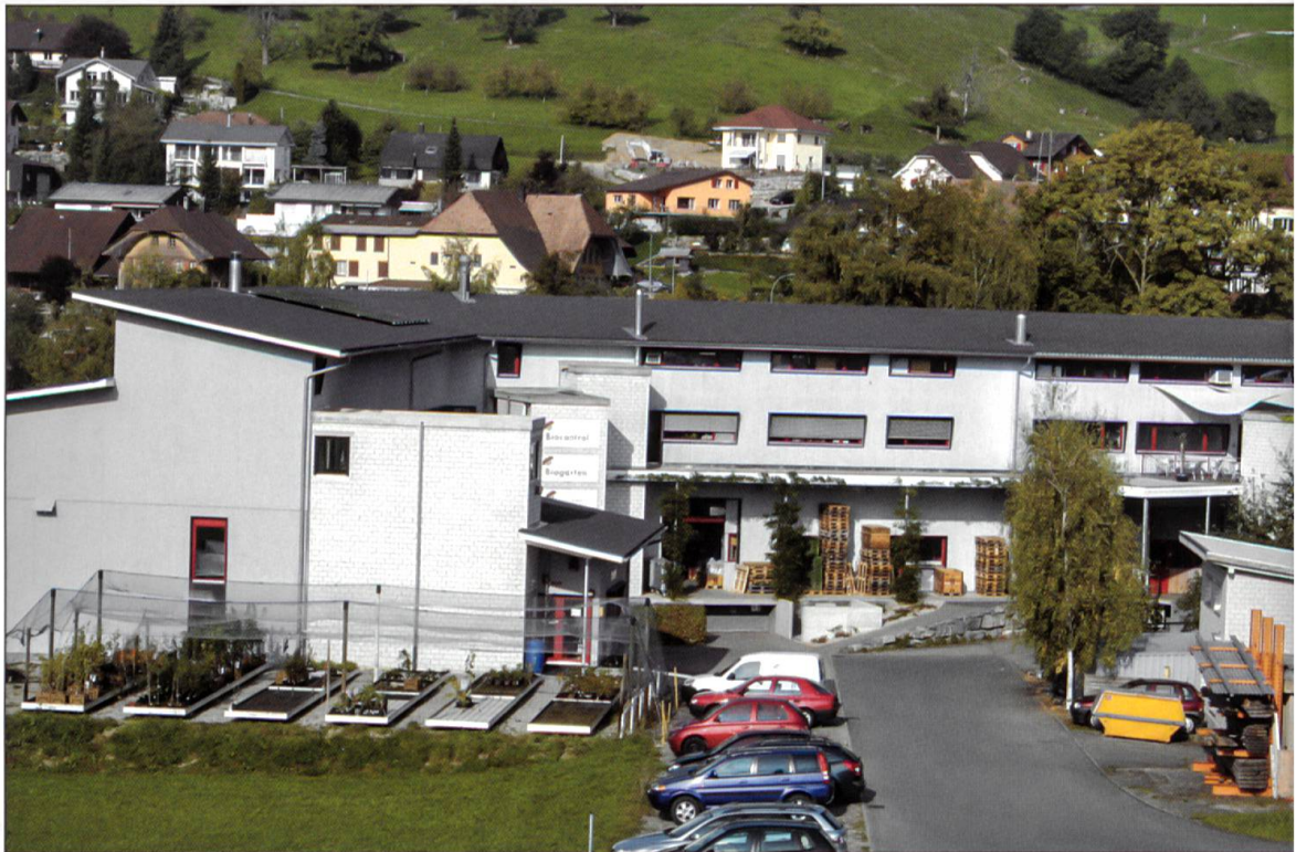
Gebäude der Andermatt-Gruppe in Grossdietwil.
