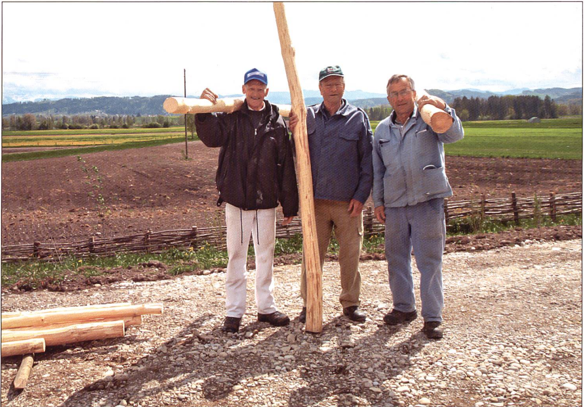
Hans Dossenbach, Schötz (rechts), kümmerte sich um alles, und das absolut professionell: von der Beschaffung des Baumaterials über das Anwerben von Freiwilligen bis hin zur Bauleitung vor Ort.
