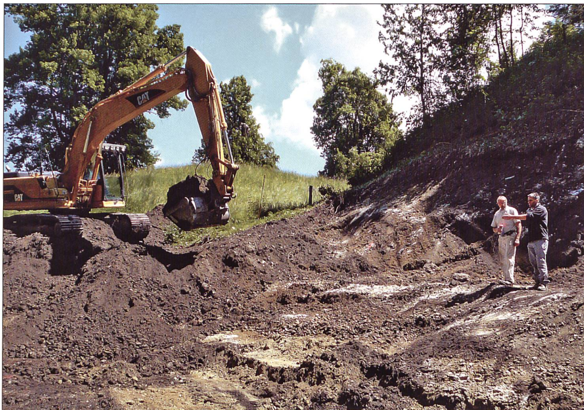
Der Aushub für den Unterstand legt den Boden des Steinbruchs frei. Aus diesem Steinbruch wurde ein Teil des Baumaterials für den Wohnturm verwendet.
