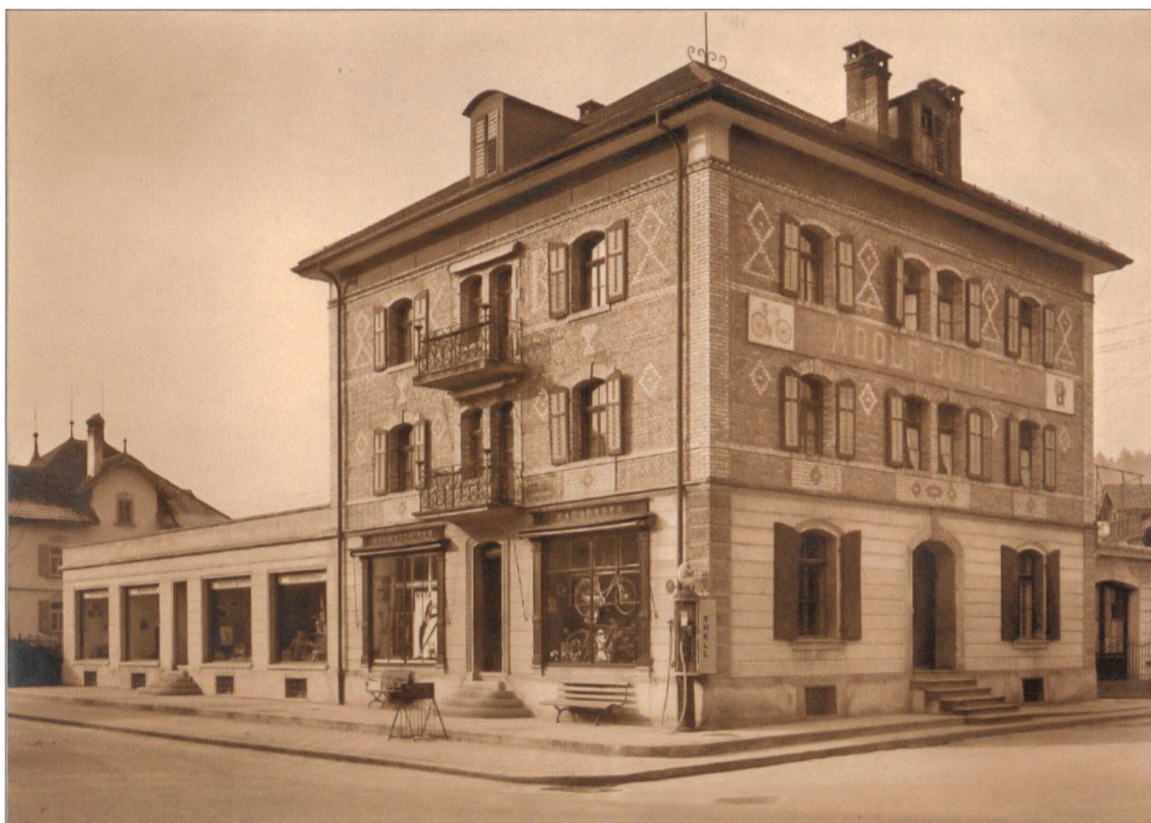
Das Geschäftshaus Bühler, wie es sich seit 1936 präsentiert. Das Hauptgebäude stammt aus dem Jahre 1899, der Werkstatt-Anbau erfolgte 1911 und die Schaufenster links im Bild stammen aus dem Jahre 1933. In der Bildmitte ist die Shell-Zapfsäule für Autos und Motos zu sehen.
