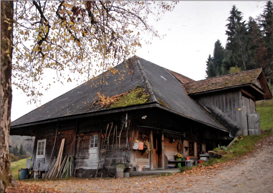
Ansicht von Norden.
