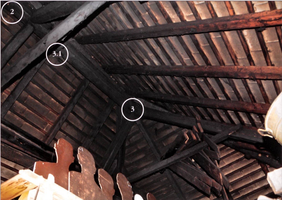
3.1 Firstverblattung Längsverstrebung zu Hochstud 3.
