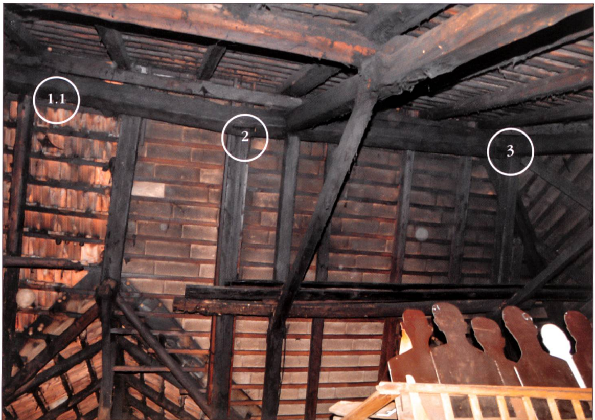
Lochbefunde an Hochstud-Firstpfette: (siehe Schema Abb. 180/181, Seite 57)
