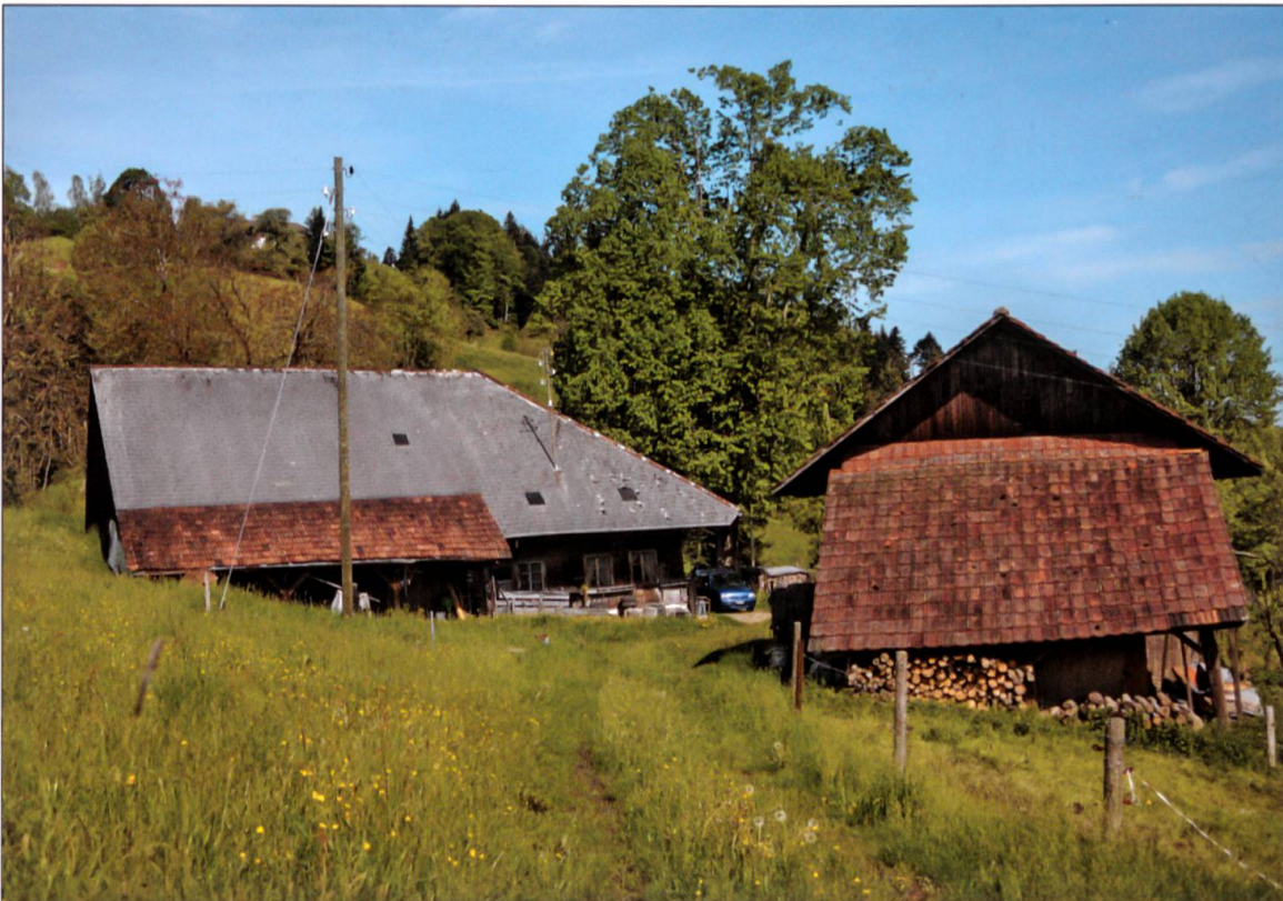
Ansicht von Osten.
