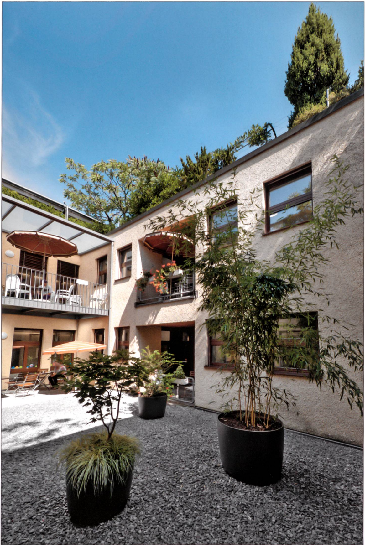
Innenhof des Aufnahmegebäudes.
