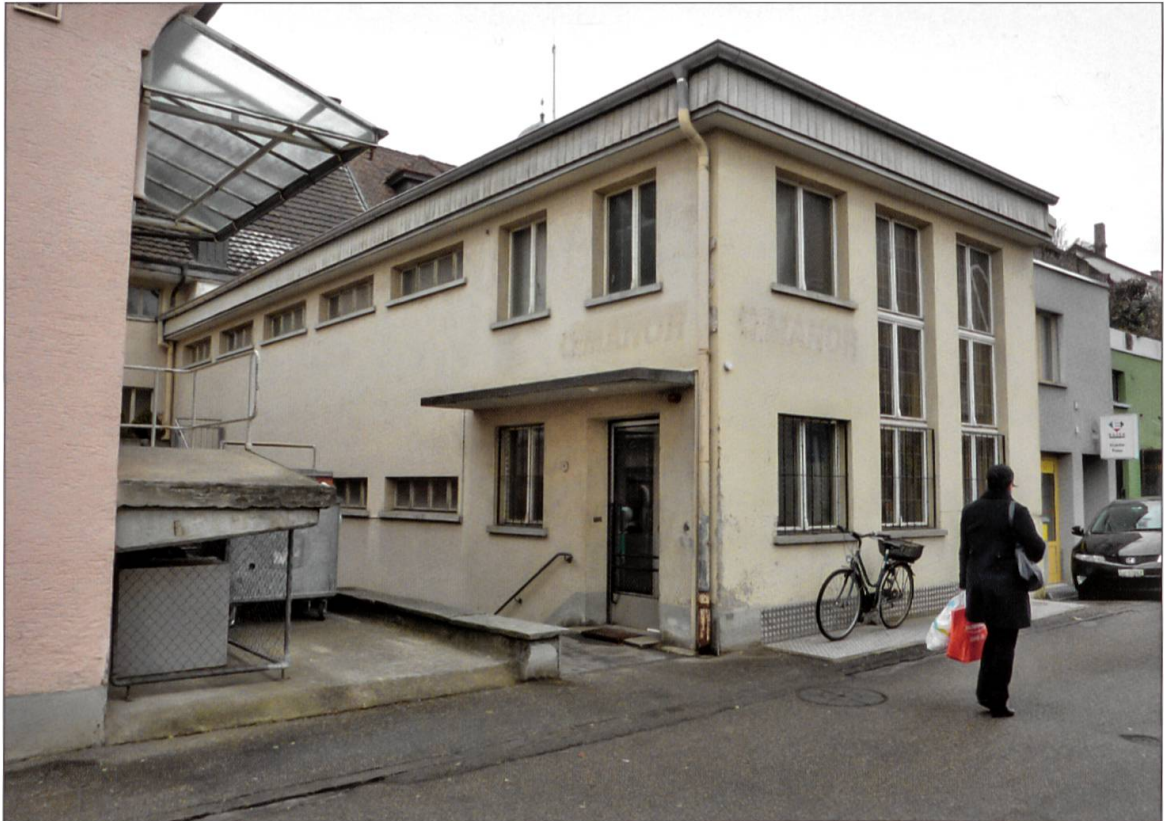
Durch den im Jahre 1952 rückseitig am Grabenweg dreigeschossig erstellten Anbau konnte die Verkaufsfläche des Warenhauses Nordmann (später Manor) wesentlich vergrössert werden.
