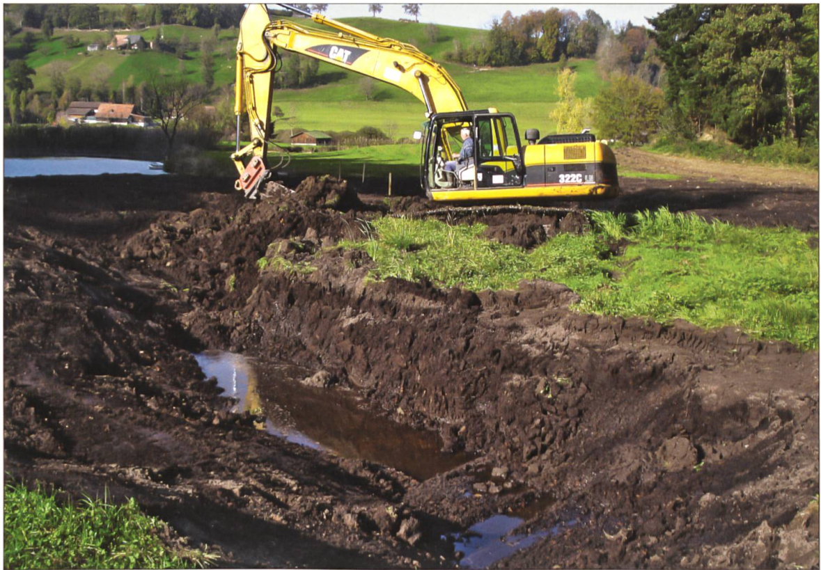
Mit Baggereinsatz wird ein neuer Weiber geschaffen.
