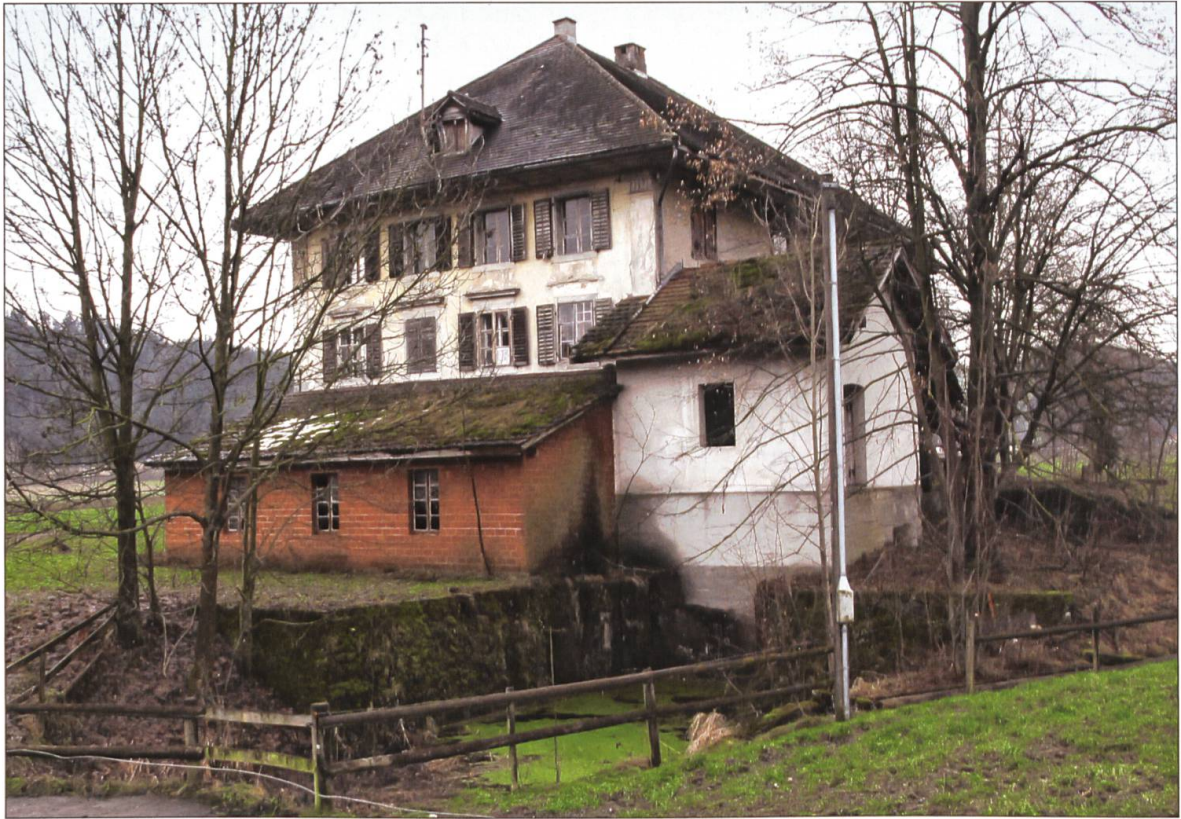
Nordansicht mit Anbau und Turbinenhaus.
