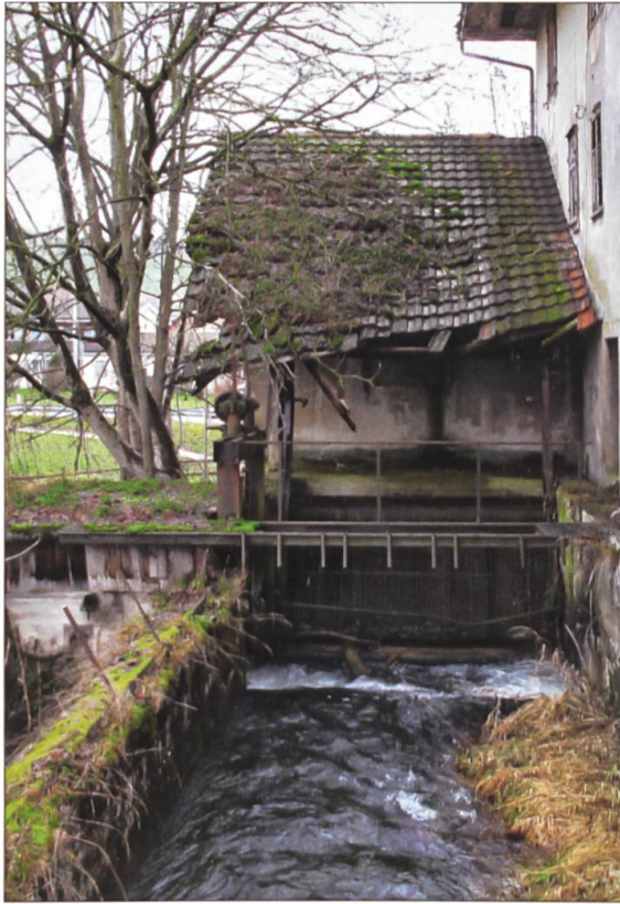
Oberwasser mit Turbinenbaus.
