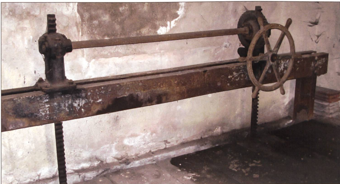
Zahnstangenbetriebene Einlaufschützen über der Turbinenkammer.
