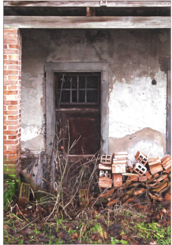
Eingang zum Hochparterre, Südseite.
