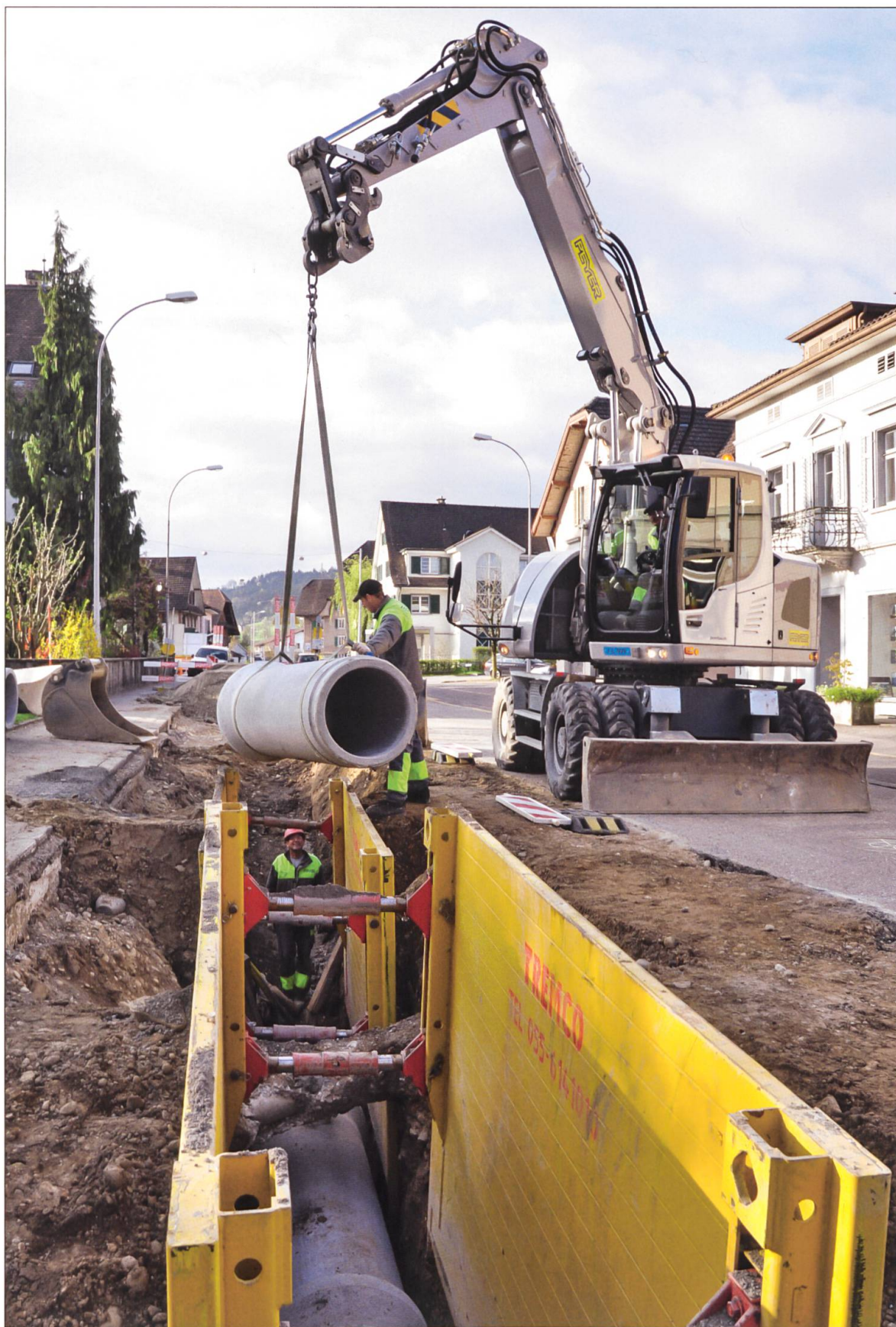
Die gleiche Arbeit mit dem Hydraulikbagger und einer Elementspriessung 2014 in Ettiswil.
