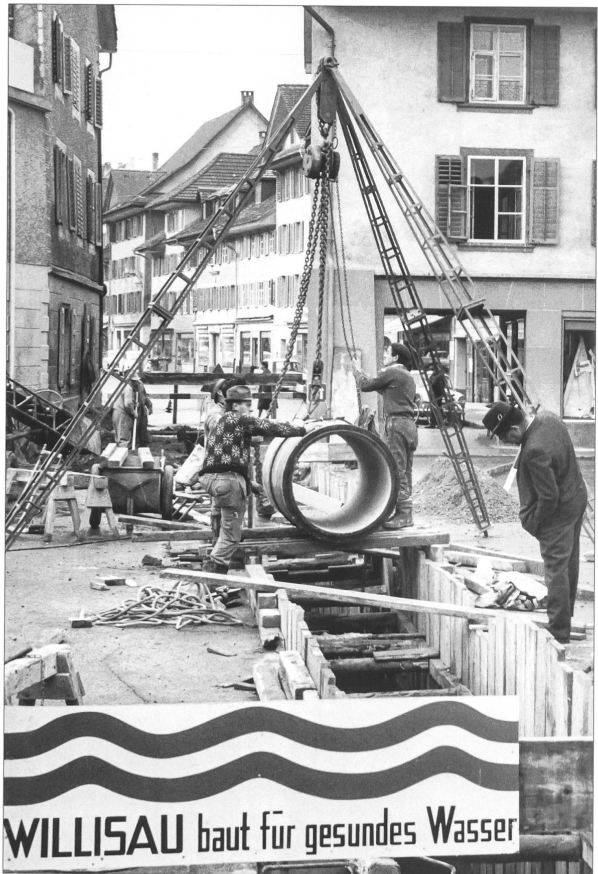
Verlegen von Kanalisationsrohren auf dem Postplatz Willisau, 1967.
