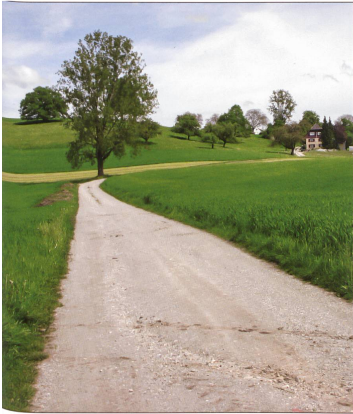
Linde bei der Strassengabelung Galgen. Rechts führt die alte Bernstrasse nach Ufhusen. Nach links zweigt die im Jahre 1880 erbaute neue Talstrasse ab.
