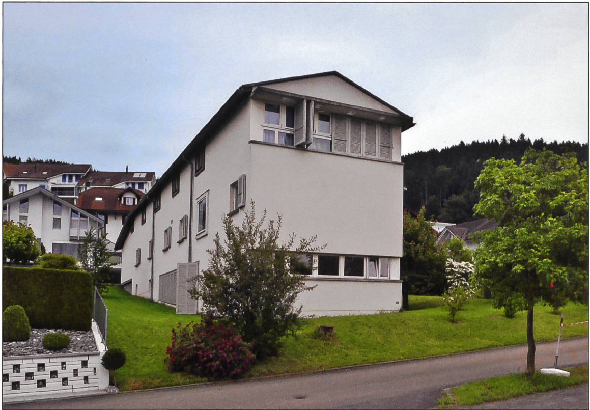
Westfassade übereck mit Nordfassade.
