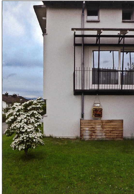
Farbigkeit der Fassade.
