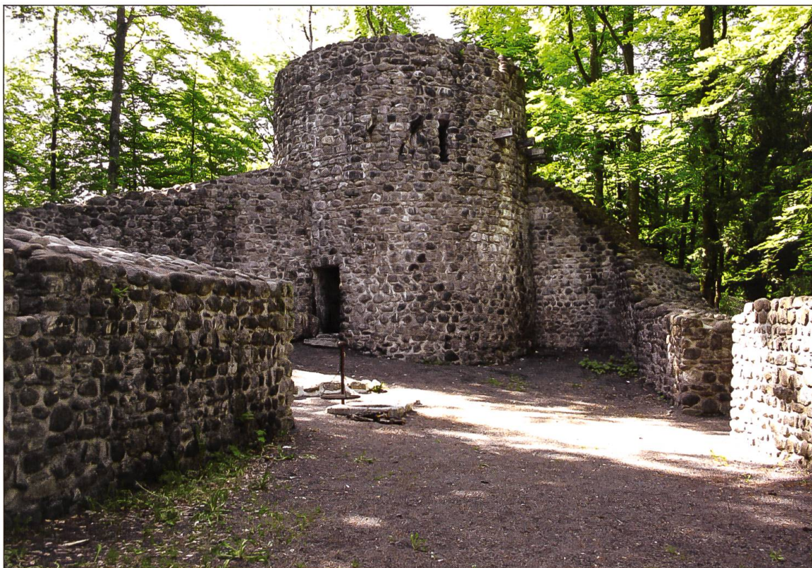
Die Ruine der Wildenburg, im 13. und 14. Jahrhundert einer der wichtigsten Sitze der Hünenberger, liegt auf einem Felsporn im Lorzentobel, auf der halben Strecke zwischen Baar und dem Ägerital. Sie ist als die einzige gut erhaltene Burganlage im Besitz des Kantons Zug. Zwei Fusswege führen zur ummauerten Anlage mit mächtigem Turm.
