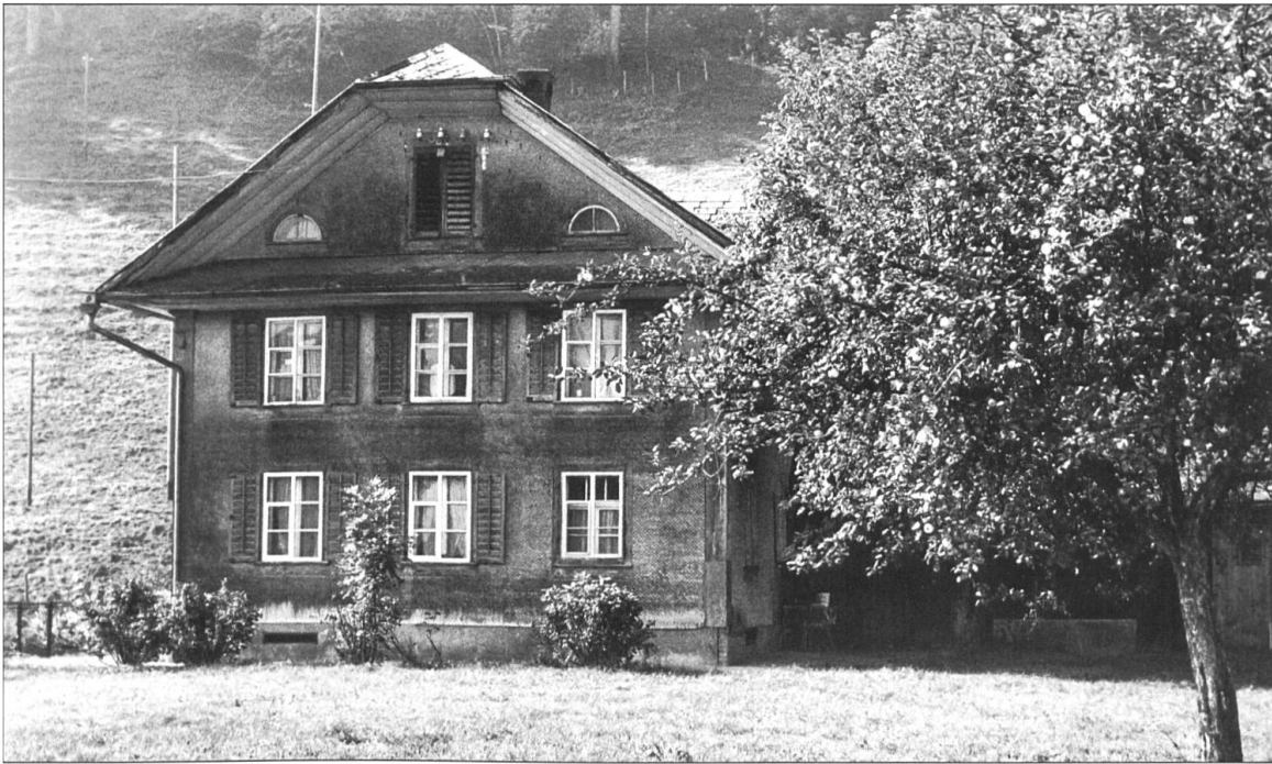
Das Bauernhaus auf der Bisangmatt, das von 1887 bis 1925 als Pfarrhaus, dann weitere 40 Jahre als Sigristenhaus diente. Gegen Ende des letzten Jahrhunderts wurde das Haus abgebrochen, an seiner Stelle platzierte die Stadt Willisau Wohncontainer für Asylsuchende.
