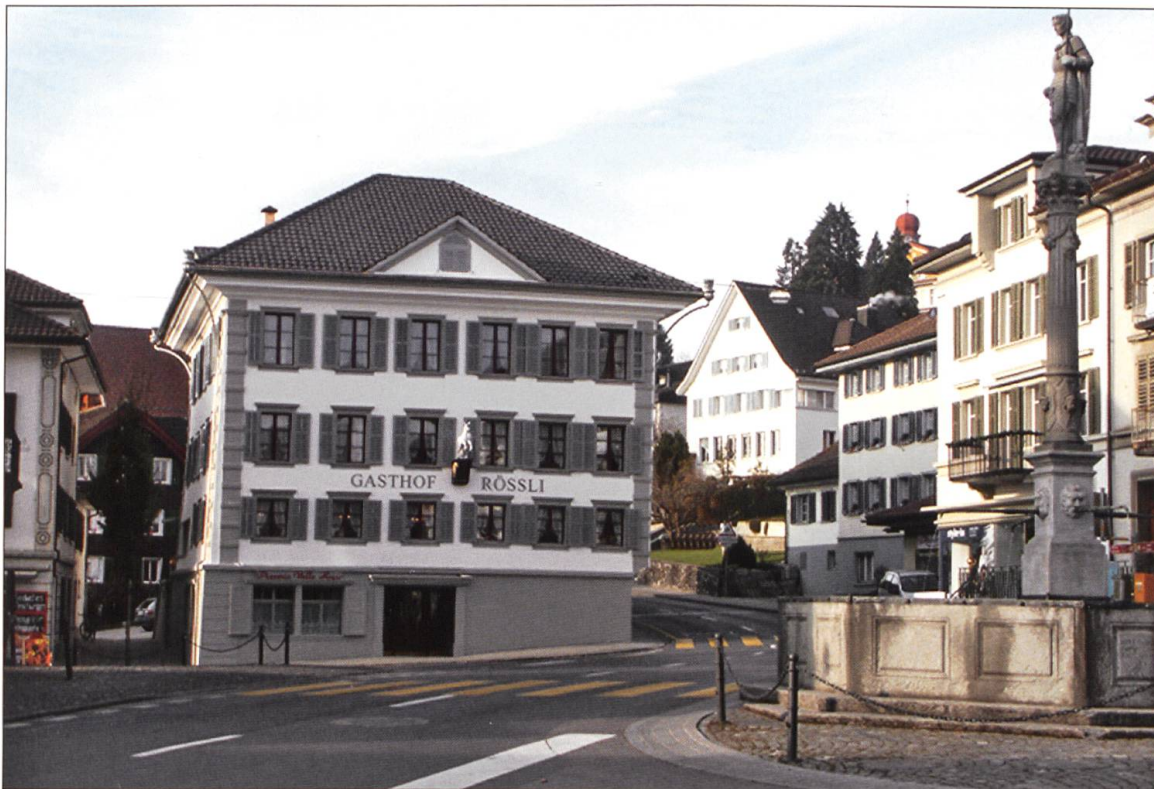
Das Gasthaus Rössli nach der Fassaden-Renovation von 2004.
