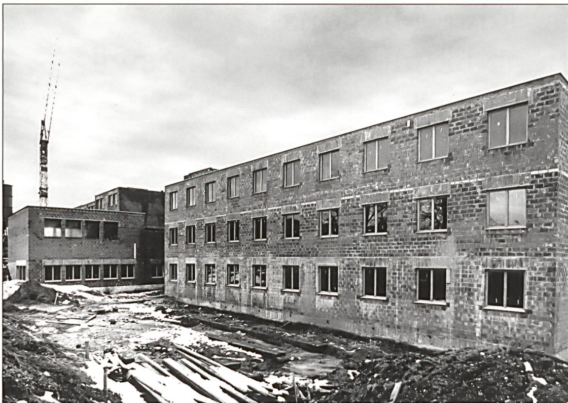
Der Robbau des neuen Alters- und Pflegeheims ist weit fortgeschritten.
