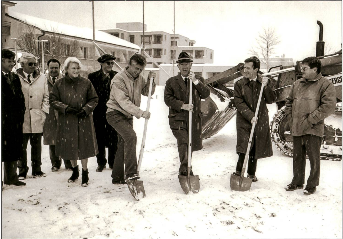
Spatenstich zum Eugen Meyer Haus, 24. Februar 1986 – v.l.n.r.: Erwin Kammermann; zwei Vertreter Amt für Wohnungsbau; Josette Peter; Bruno Stöckli, Innenarchitekt; Arno Wüest, Architekt; Eugen Meyer; Robert Oberli, Bürgerratspräsident; Rudolf Achermann, Bauführer.
