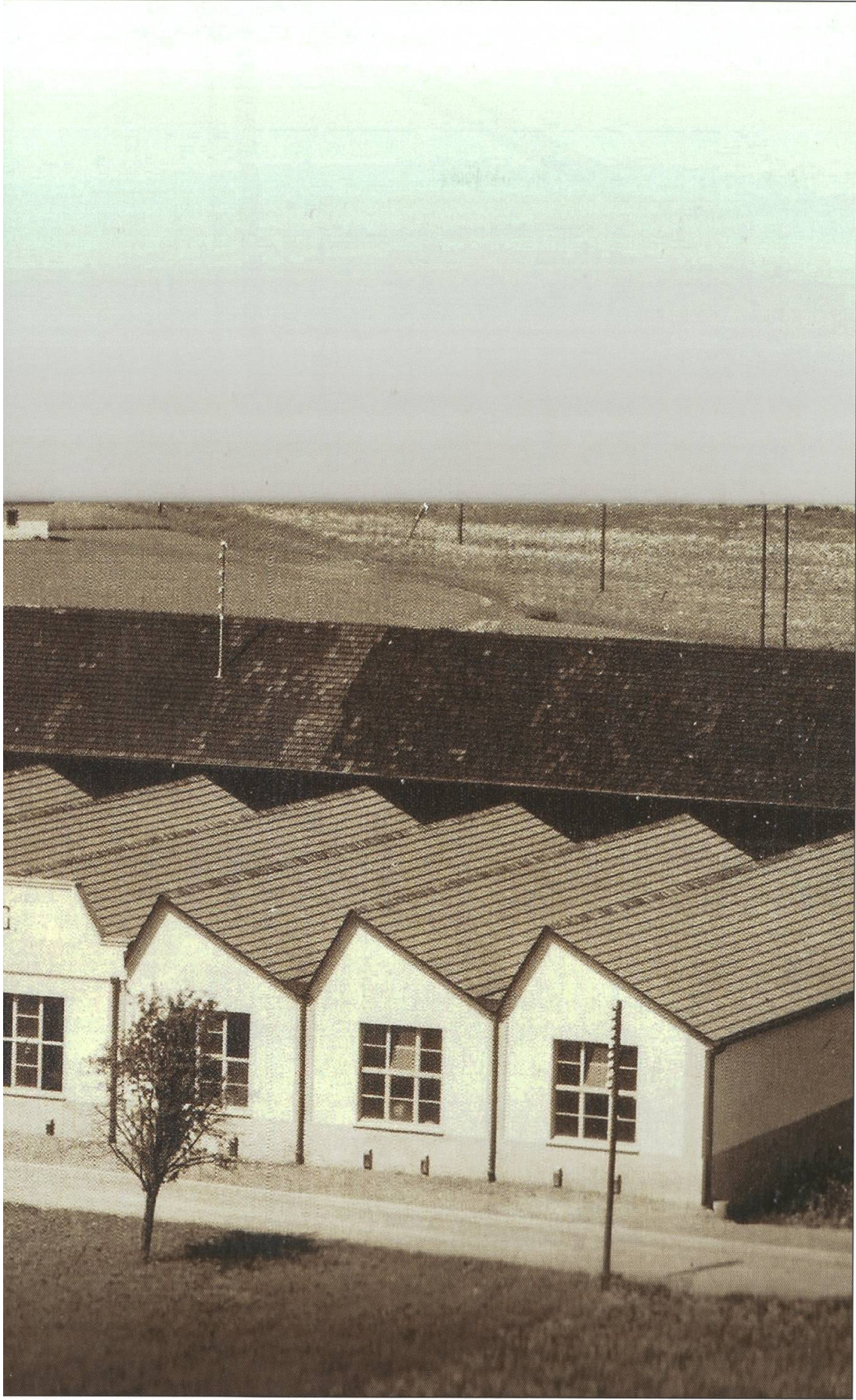
Abbildung 1. Die Südfassade der 1929 errichteten Möbelfabrik Willisau AG, die die sägezahnförmigen Elemente des Sheddachs in die Gestaltung aufnimmt. Fotograf unbekannt
