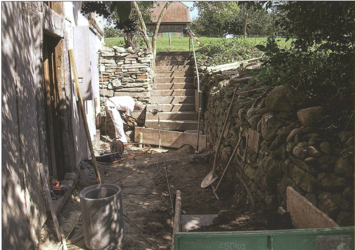
Sanierung im September 2009 des Kellerzugangs und der Abwasser- und Wasserleitungen.
