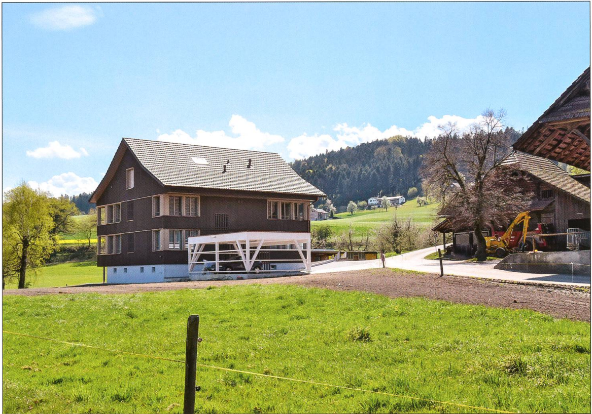
Die Situation im April 2020. Der Carport ist noch nicht eingeschalt. Rechts der Spycher und die Scheune.
