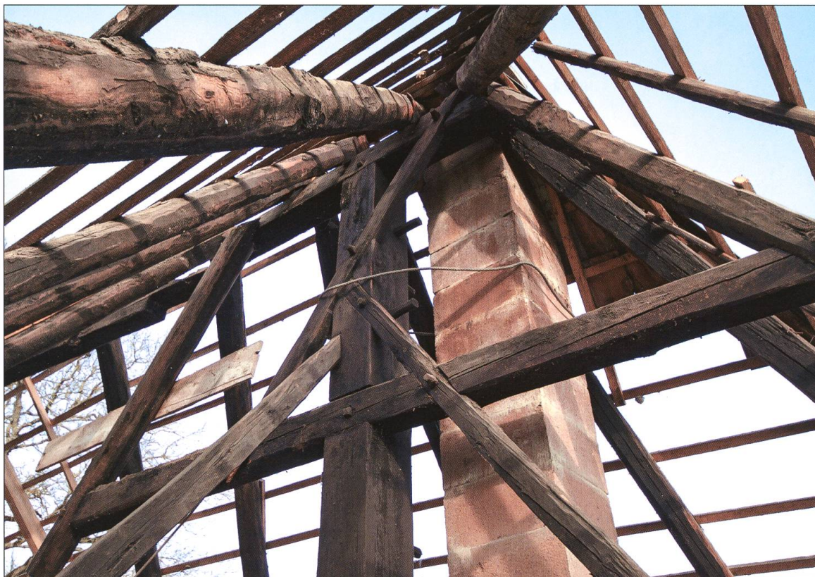
Firständer aus erster Bauphase, November 2019.
