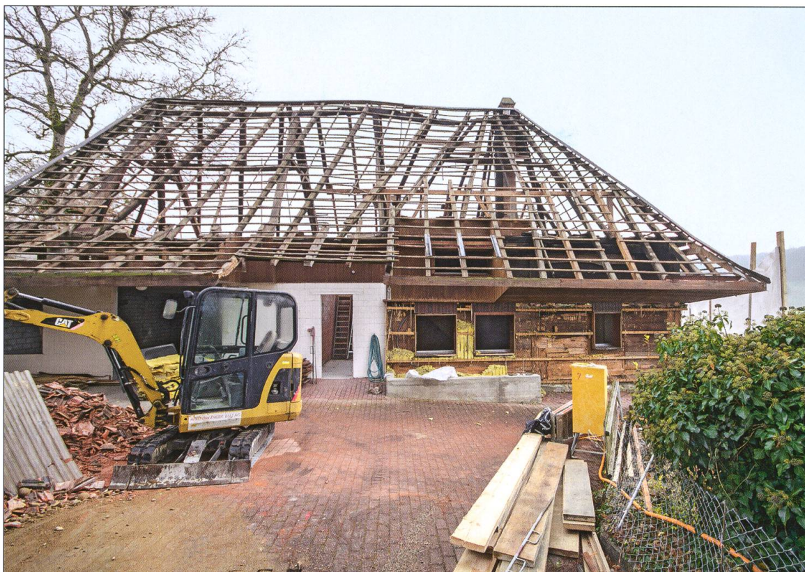
Ansicht der Westfassade, November 2019.
