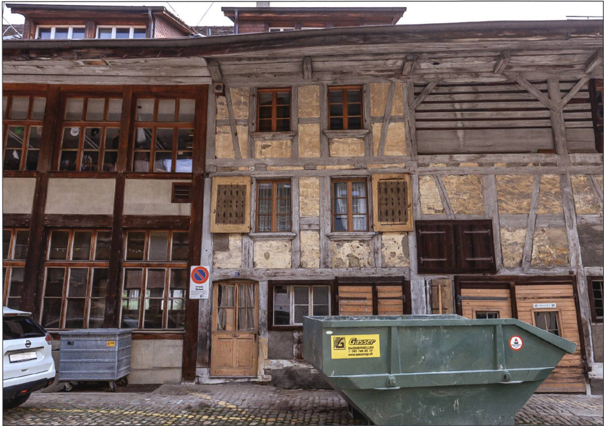
Abb. 7 Ansicht der Nordfassade der Liegenschaften Letzigasse 10 und 12. Rechts die ursprüngliche Riegel-Bohlen-Konstruktion, links die im 20. Jahrhundert erneuerte Fassade der abpartzellierten Wohntrakthälfte. Foto Cecilie Gut
