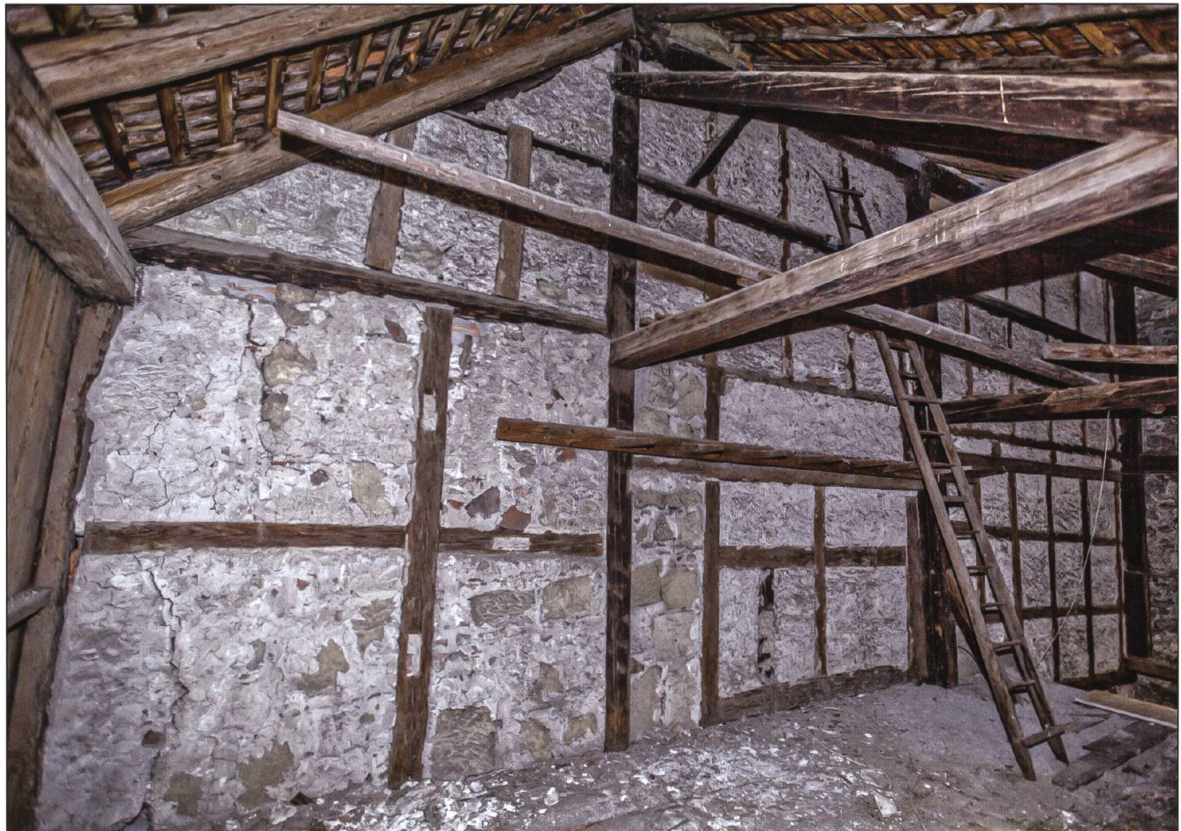
Abb. 3 Südansicht der nachträglich in mehreren Phasen entstandenen Riegelwand im Dachstuhl zwischen dem Wohn- und dem Ökonomietrakt (18./19. Jahrhundert). Die darin eingelassenen, rauchschwarzen Ständer und Verstrebrungen gehören zur Firstständerkonstruktion von 1462/63. Foto Theo Frey
