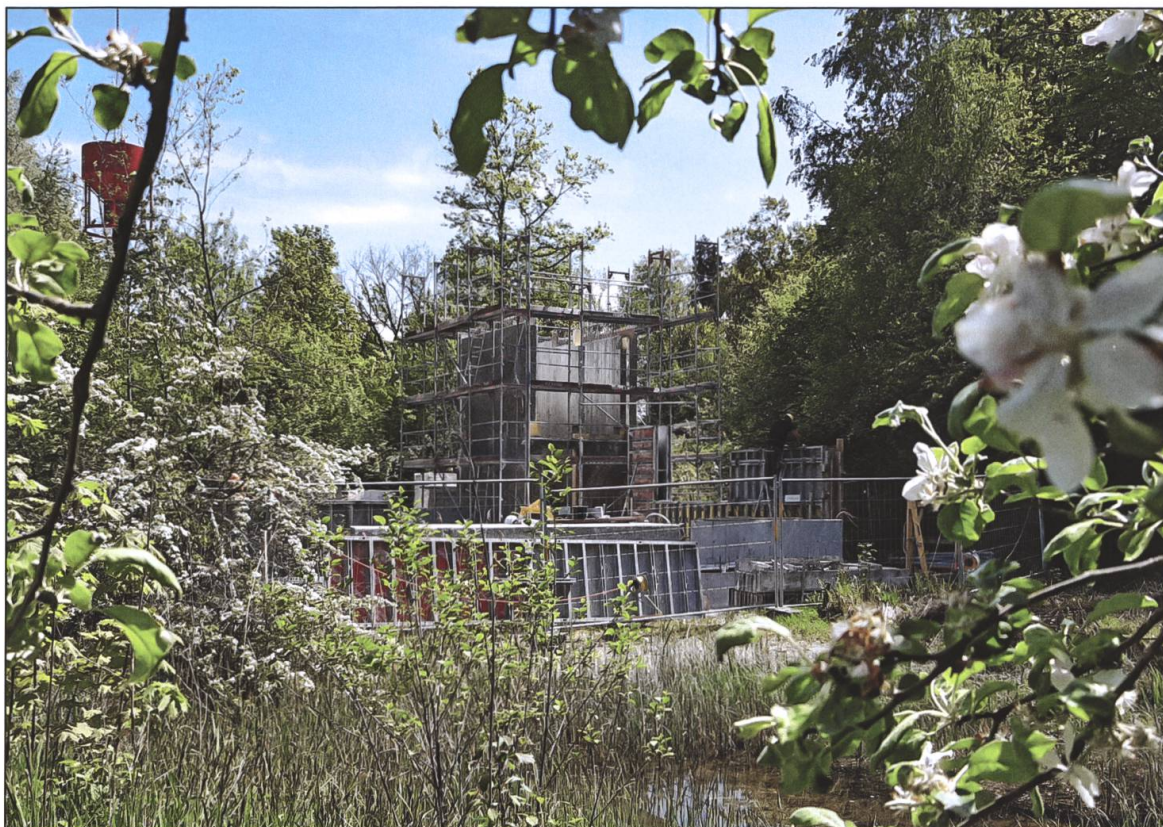
Bau des neuen Naturzentrums.
