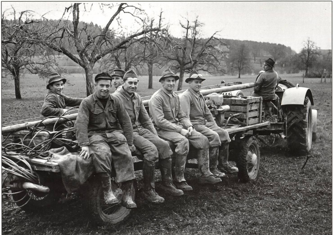
Eine staatlich finanzierte Baumfällerguppe mit sechs Mann unterwegs.
